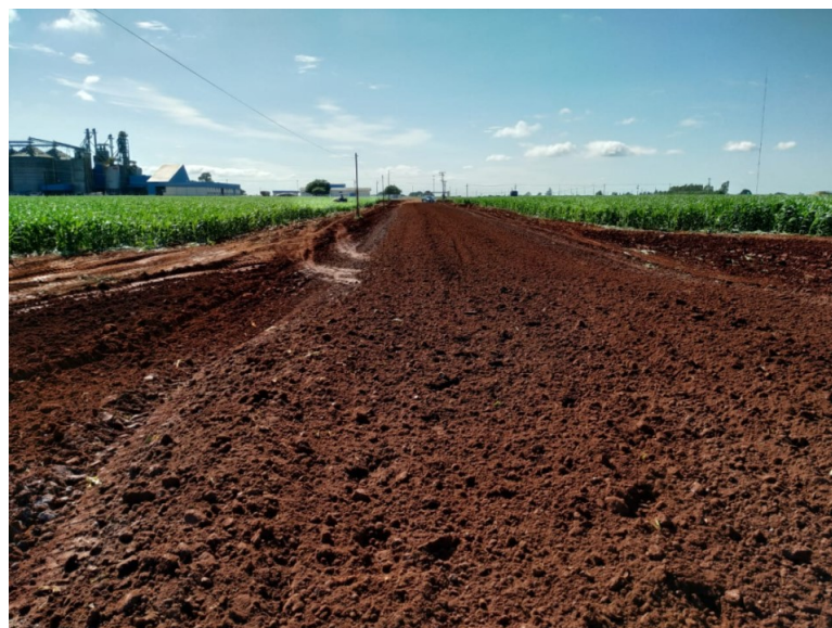
Figura 4: Verificação da umidade do solo “ideal” para compactação
