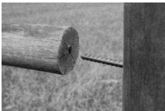
Figura 20: Trava com pino cavilha
